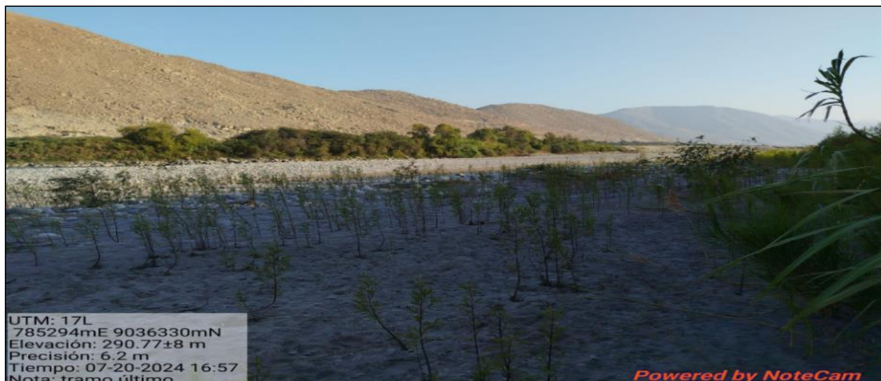
FIGURA N°02: EXCESIVA COLMATACION DEL RIO SANTA A LA ALTURA DE LA TOMA CAPTACION PONTE, ANTE UNA CRECIDA SE ESTARIAN AFECTANDO DICHA CPATACION Y MAS DE 20 HAS DE CULTIVO.
